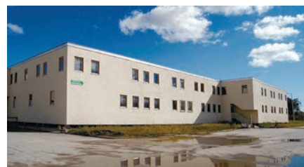
Рис.6. Здание патологоанатомического отдела ГБУ РС(Я) «РБ №1-Национальный центр медицины» (с 1992 г. по настоящее время)
